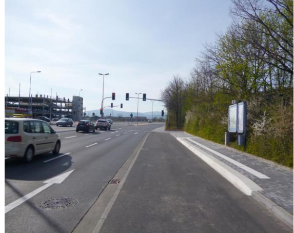
Zwei gegenüberliegende Haltebuchten am neuen Krankenhaus auf der L 3003 sind vorbereitet für den X26. Bis zum Krankenseingang sind es von hier 300 Meter Fußweg – nahezu unzumutbar für Gehbehinderte und Rollstuhlfahrer.
