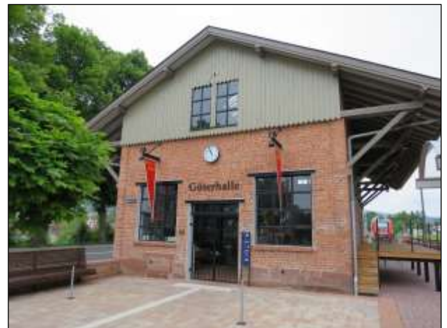
Die heute als Empfangsgebäude genutzte ehemalige Güterhalle in Erbach. (Foto: Reinhard Dietrich)
