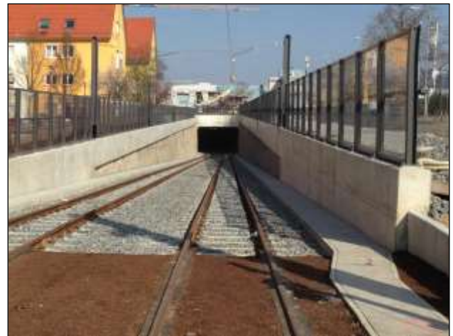
Ein Tunnel unter der Bahnstrecke „Östliche Riedbahn“ ist der kostspieligste Bauteil der Stadtbahn Nord.
