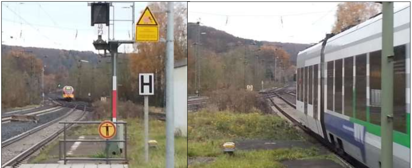
In Guntershausen trennen sich die Gleise nach Treysa (links) und Melsungen (rechts). (Fotos: Thomas Kraft)
