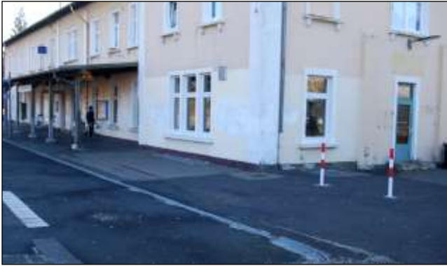
Einen barrierefreien Zugang zum Bahnhof Lauterbach gibt es von der Gleisseite. (Fotos: Werner Filzinger)
