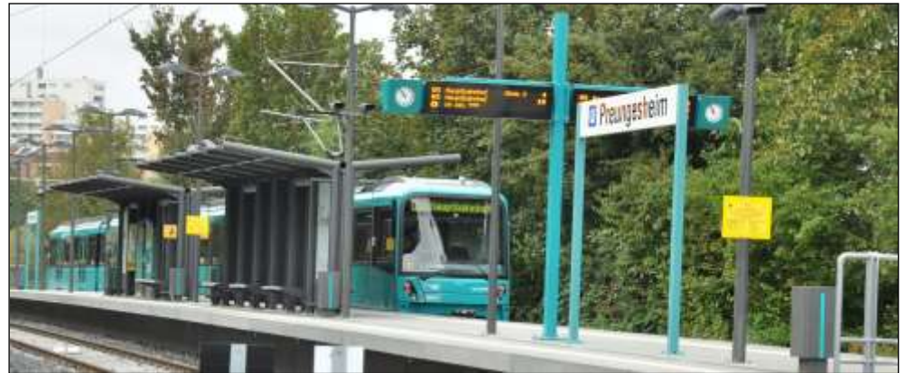
Die umgebaute Endhaltestelle Preungesheim mit einem neuen Zug vom Typ U5.
