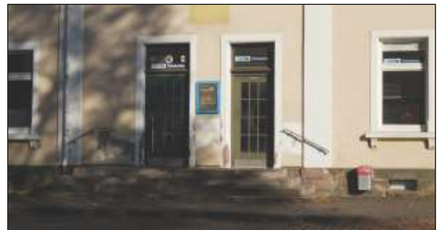
Nicht barrierefrei: Vordereingang des Bahnhofes in Lauterbach.
