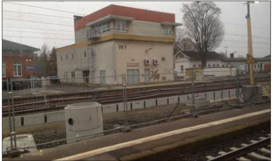
Umbau der Bahnsteige in Wabern. (Foto: wb)
