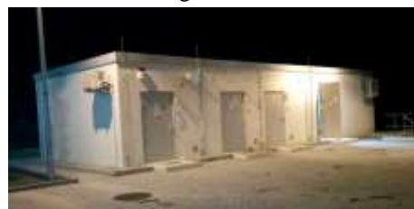
Das elektronische Stellwerk in Friedberg. (Foto: Reinhard Ahrens)
