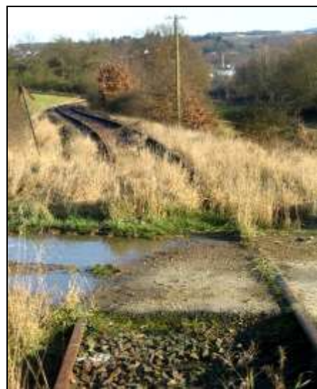
In desolatem Zustand: Strecke bei Simmern. (Foto: Marcus Braun)
