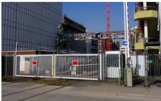
Einfahrt zum BASF-Werksgelände am Südtor. (Foto: gip)
