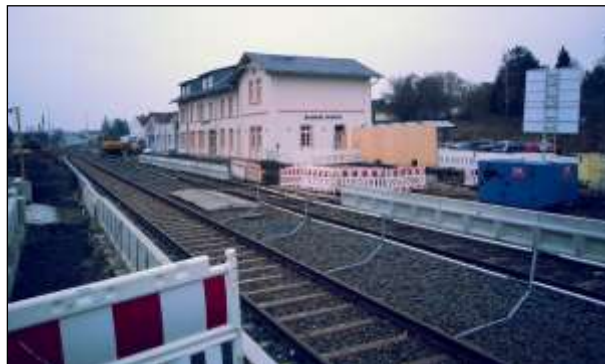
Bahnhofsbaustelle Hungen (Foto: Thomas Kraft)
