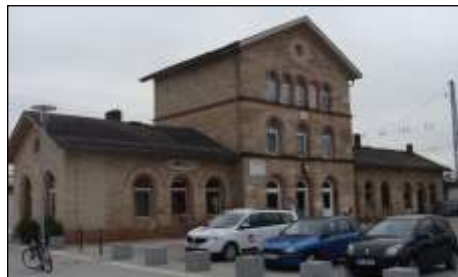
Bahnhof Babenhausen (Foto: Th. Kraft)
