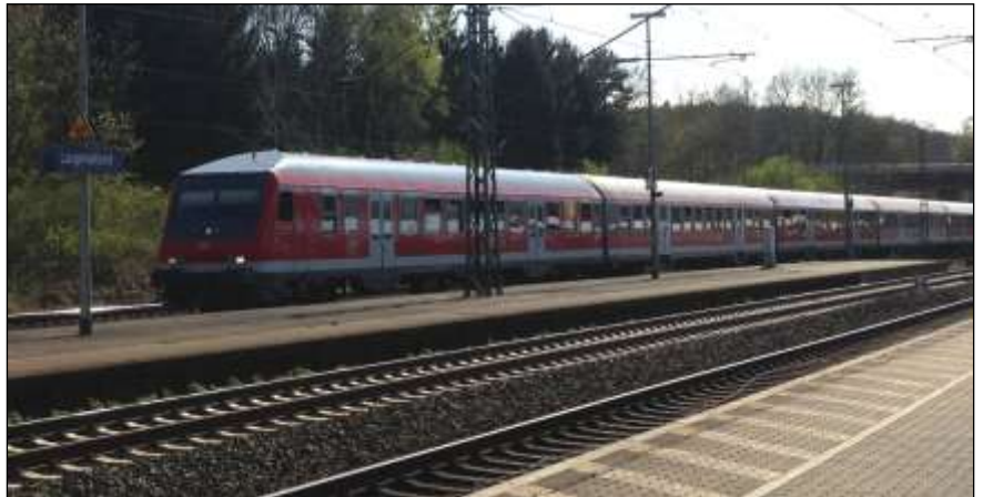
Bahnhof Langenselbold. Immer wieder müssen hier Nahverkehrszüge warten, damit schnelle ICE-Triebwagen überholen können. Der Nahverkehr würde hier schneller und flüssiger werden, wenn es hier vier Gleise gibt: zwei für den Nah- und Fernverkehr. (Foto: wb)
