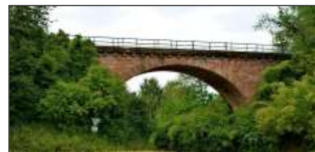
Viadukt der Bachgaubahn bei Wenigumstadt (Foto: png)
