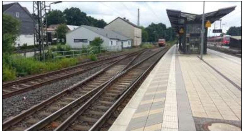
Am Gleis ganz links in Stadtallendorf könnte relativ einfach ein zusätzlicher „Hausbahnsteig“ für den Mittelhessenexpress gebaut werden. (Foto: Thomas Kraft)
