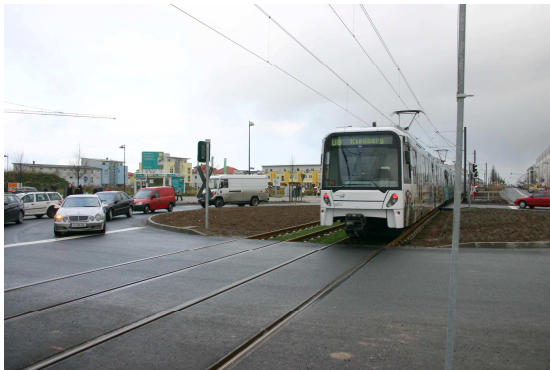
Im Zentrum des Stadtteils Riedberg kreuzt die U-Bahn die Hauptverkehrsstraße für 20.000 Bewohner und Besucher
