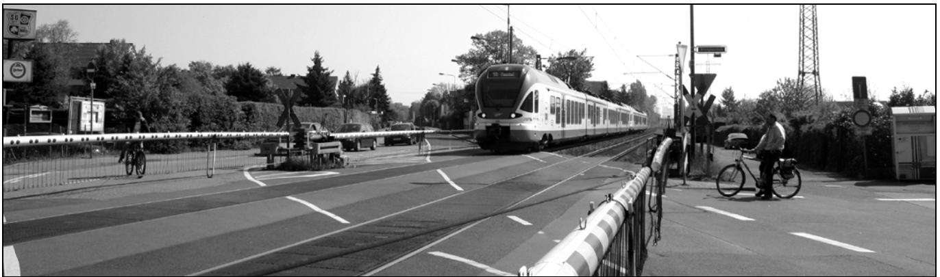
Eine Straßenabbiegung mitten auf einem Bahnübergang im Frankfurter Stadtteil Nied. Schon seit 20 Jahren soll die Gefahrenstelle beseitigt werden. (Foto: Wilfried Staub)
