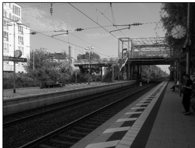
Wenig Platz für neue Schienen zwischen Heidelberg und Karlsruhe wie hier am Bahnhof Kirchheim/Rohrbach (Foto: wb)
