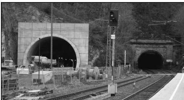
Neuer und alter Tunnel. (Foto: W. Staub)
