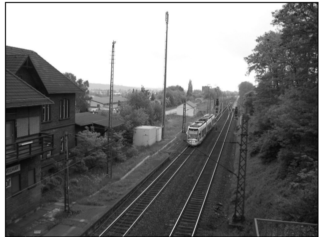
Blick in die Gegenrichtung: Hier verzweigen sich die Strecken nach Kassel-Wilhelmshöhe und zum Hbf. (Foto: hh)
