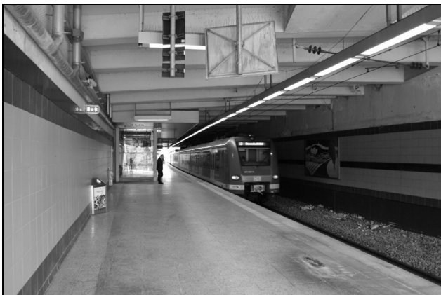
Bahnhof Schwalbach Limes mit Wasserdurchtritt (vorne) und Betonabbruch (rechts unten an der Wand). (Foto: Wilfried Staub)
