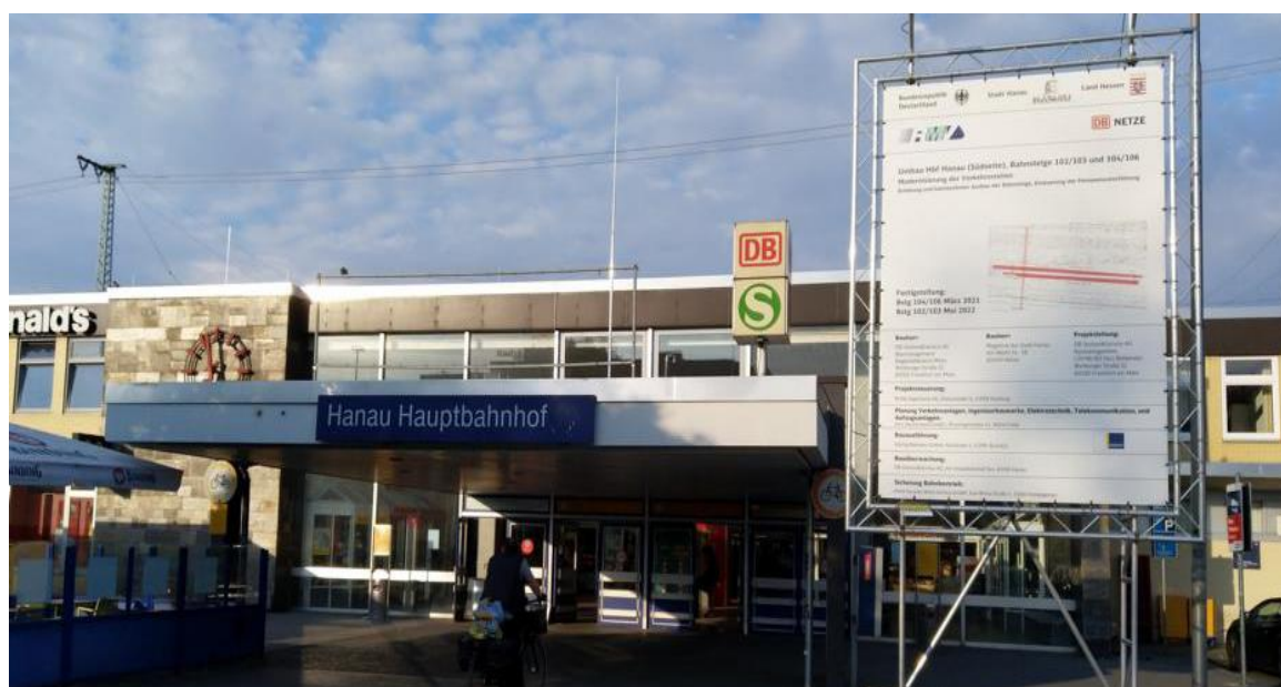
Hanau Hbf: Erforderliche Umbaumaßnahmen in Verbindung mit dem Streckenausbau auf der Kinzigtalbahn Abb. 02/22
