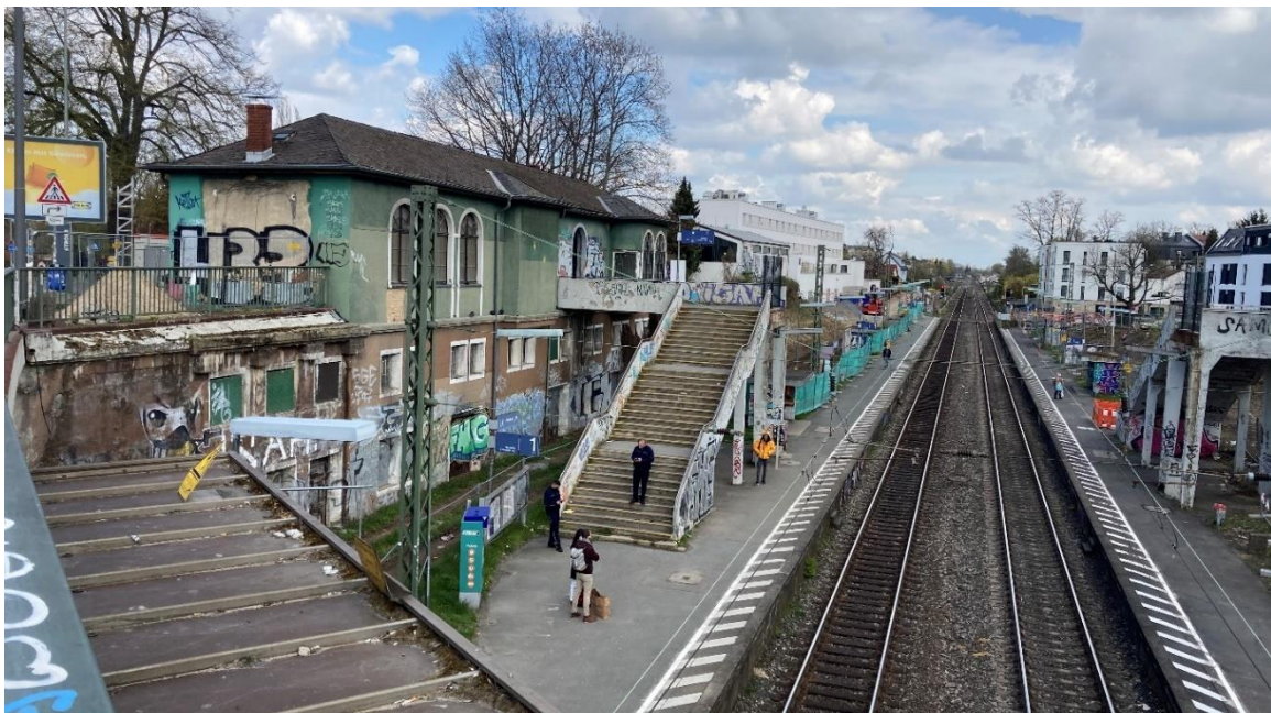
Bahnhof Eschersheim mit Empfangsgebäude und Resten des früheren südlichen Übergangs. Eine Bürgerinitiative wollte aus dem Bahnhofsgebäude ein Nachbarschaftstreff machen. Doch leider wird es wohl abgerissen. Abb.02/15
