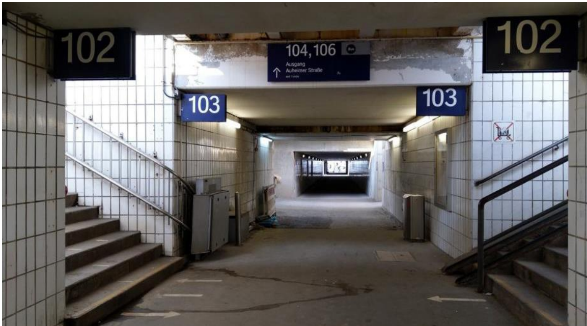
Längst überfällig, die Sanierung der Bahnsteigunterführung und Herstellung eines barrierefreien Zugangs Abb. 02/23
