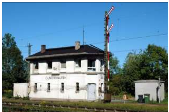
Bis Guntershausen müssen die Schienen ausgebaut werden. (Foto: K. Jähne)
