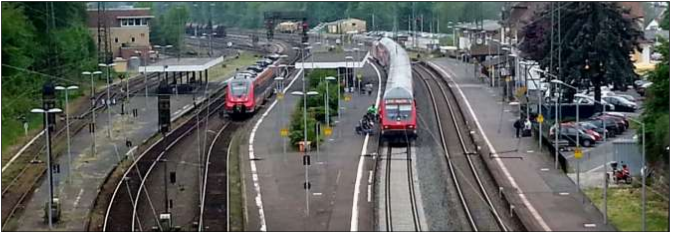
Bahnhof Treysa: Ganz links ist noch das stillgelegte Gleis 5 zu sehen, aus dem die Züge nach Malsfeld/Eschwege und Niederaula abfahren (Fotos: Thomas Kraft).
