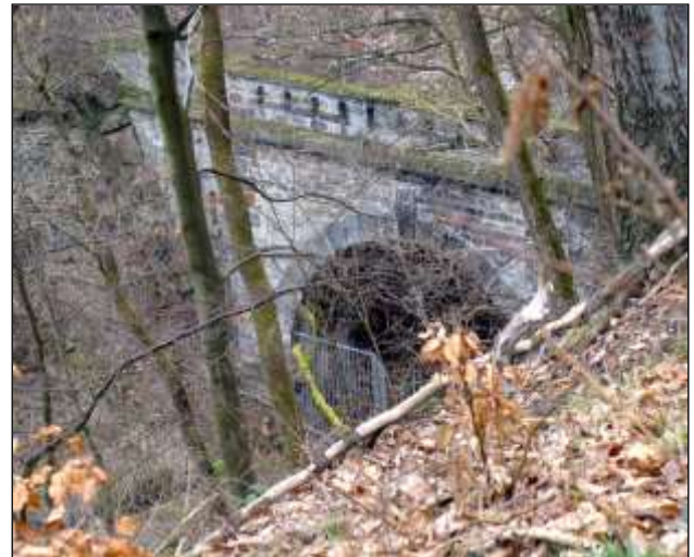
Versteckt im Wald: Ein Portal des Oberbeisheimer Tunnels.
