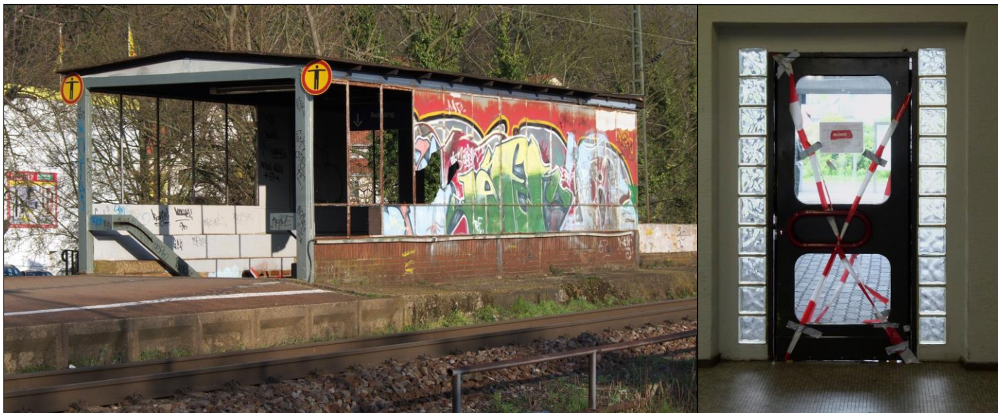
Keiner interessiert sich für den Zustand der Bahnhöfe und Haltepunkte im Saarland: Links der Bahnhof Saarbrücken Ost, rechts eine defekte Tür in Saarlouis, die über Monate nicht repariert wurde. (Fotos: Erhard Pitzius)
