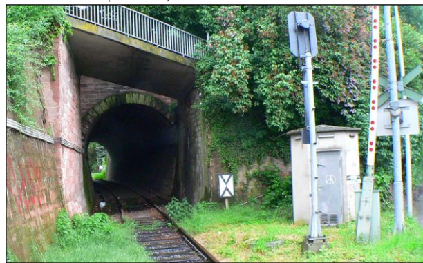
Tunnel an dem noch existierenden Teil der Gersprenztalbahn in Reinheim. (Foto: Pressebild)
