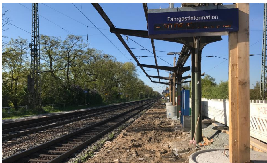
Ein aktuelles Beispiel für Bahnhofssanierung in Hessen ist Darmstadt-Eberstadt. Wenn die Modernisierung im Jahre 2019 abgeschlossen sein wird, dann sind die beiden Bahnsteige auf eine Höhe von 76 cm und eine Länge von 210 m gebracht und es werden ein modernes Dach sowie zeitgemäße Kundeninformationen und Aufzüge installiert sein - Gesamtkosten: 8,9 Millionen Euro. (Fotos: Benjamin Schmidt/DB)
