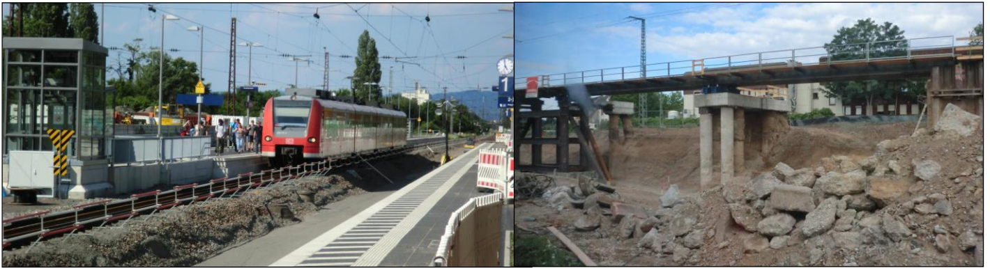
An der Main-Neckar-Bahn wird gebaut. Gerade abgeschlossen ist der Umbau des Bahnhofes Ladenburg (Bild links): Neu errichtet wird auch ein Überwerfungsbauwerk im Trennungsbahnhof Mannheim-Friedrichsfeld, der seit dem Fahrplanwechsel Neu-Edingen-Friedrichsfeld heißt, weil er weitgehend Teil auf der Gemarkung von Edingen im Rhein-Neckar-Kreis liegt. (Fotos: Axel Juedtz)
