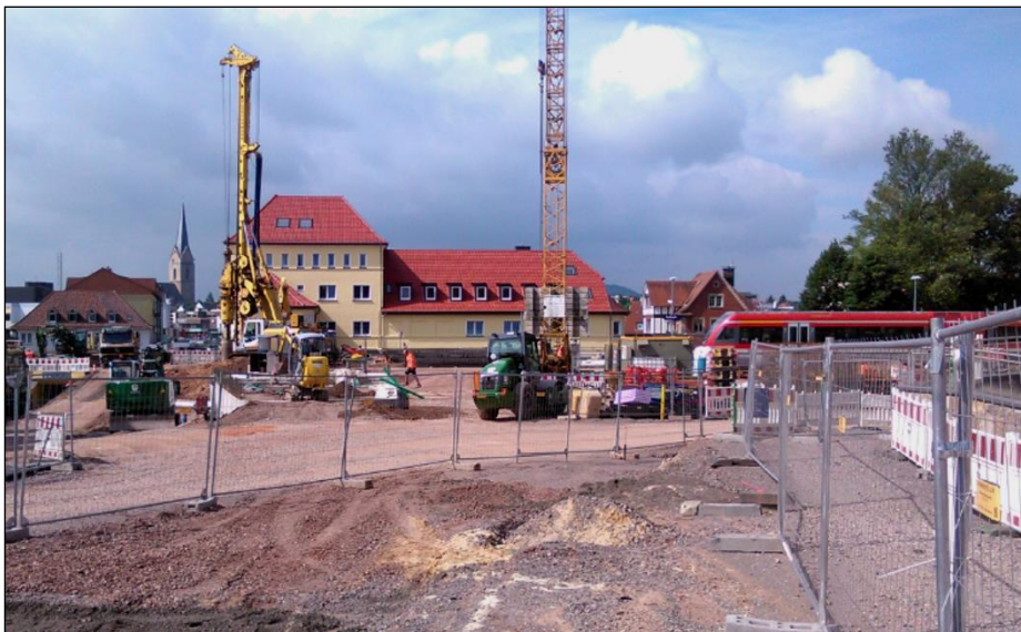
Riesenbaustelle um den Korbacher Bahnhof: Rechtzeitig vor dem Hessentag 2018 in der Hansestadt entsteht dort eine neue Busstation. (Foto: Jobst Conrad)
