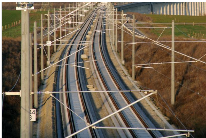
Wann werden neue Gleise verlegt? (Foto: DB)
