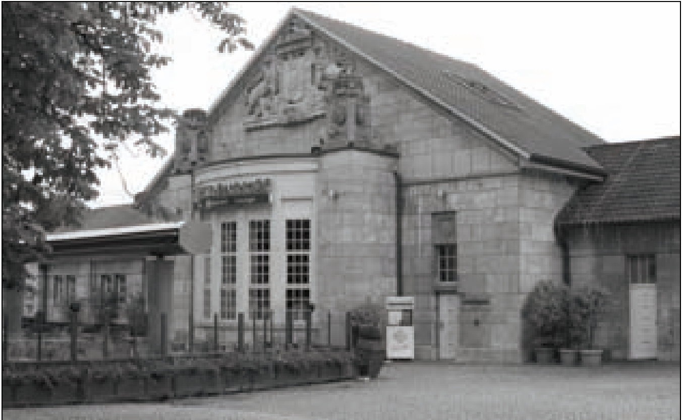
Der Fürstenbahnhof in Darmstadt, Teil des Hauptbahnhofs. (Foto: Reinhard Dietrich)
