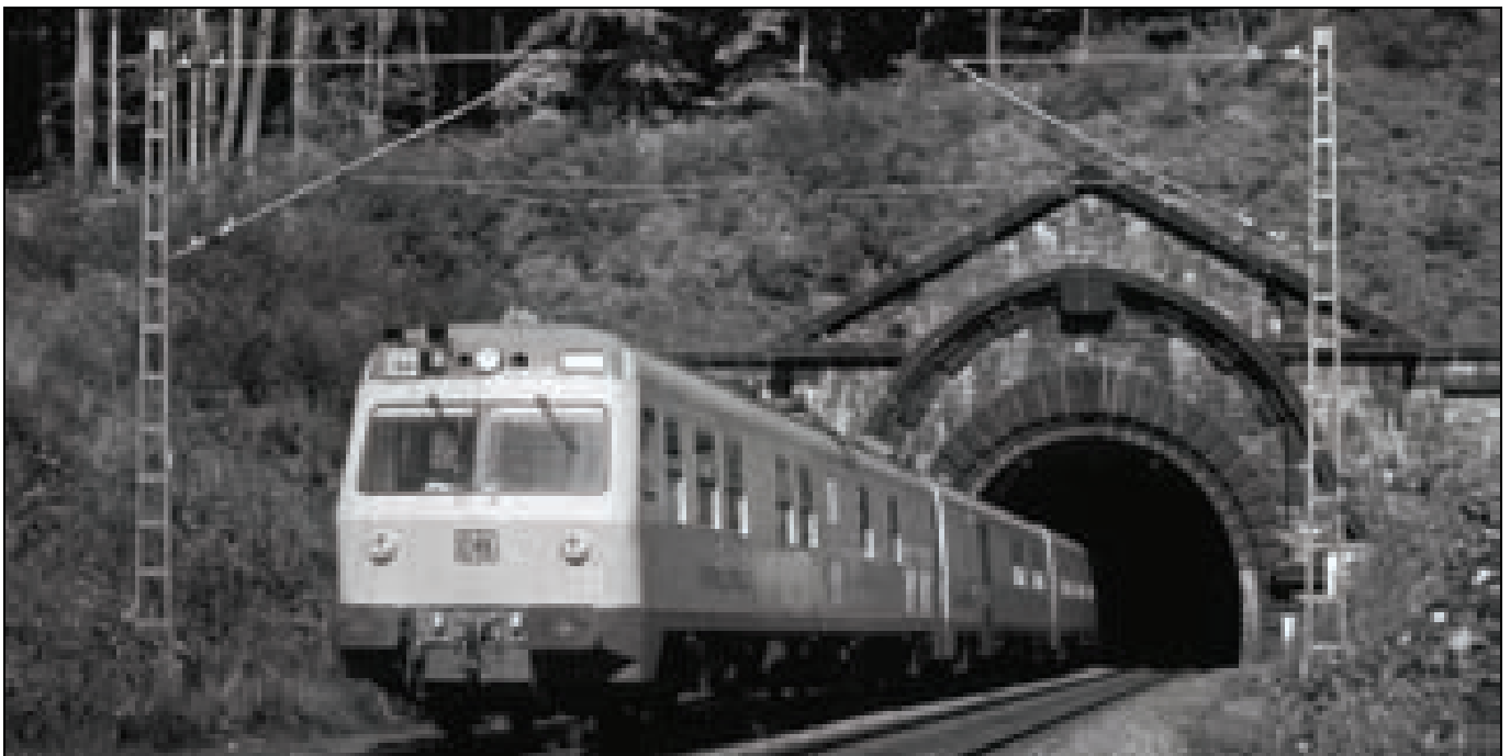
Ultraschall-Schienenprüfzug bei Ausfahrt aus dem alten Schlüchterner Tunnel. (Foto: DB AG/Georg Wagner)
