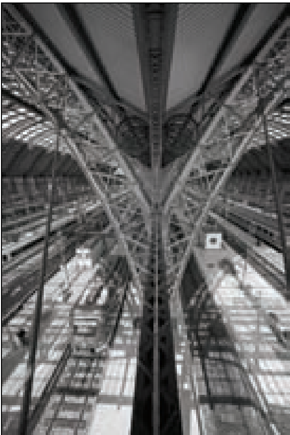
Die unter Denkmalschutz stehende Konstruktion des Frankfurter Hauptbahnhofs stellten die Planer von Frankfurt 21 vor große Probleme (Foto: DB AG)
