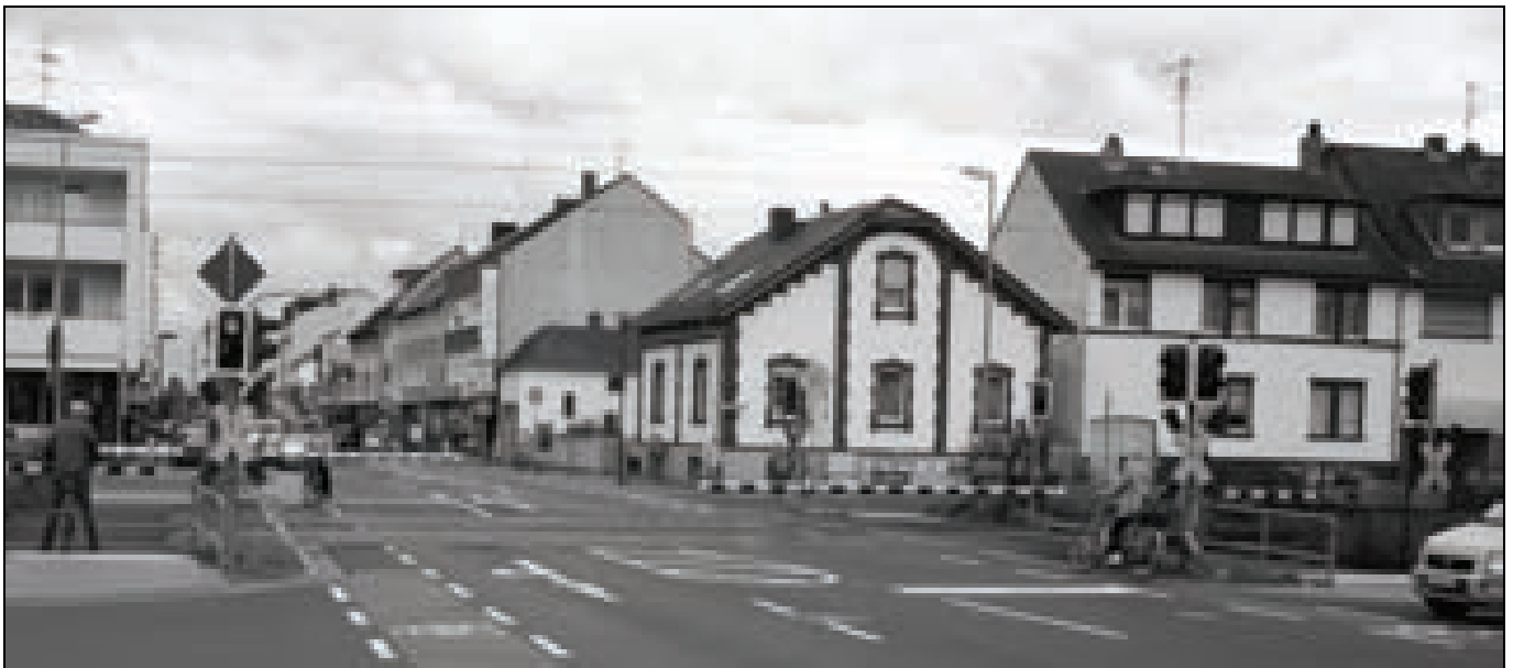
Bahnübergang direkt am Bahnhof Heusenstamm. Bebauung und Straßenanbindungen erlauben hier nicht den Bau einer Unterführung.
